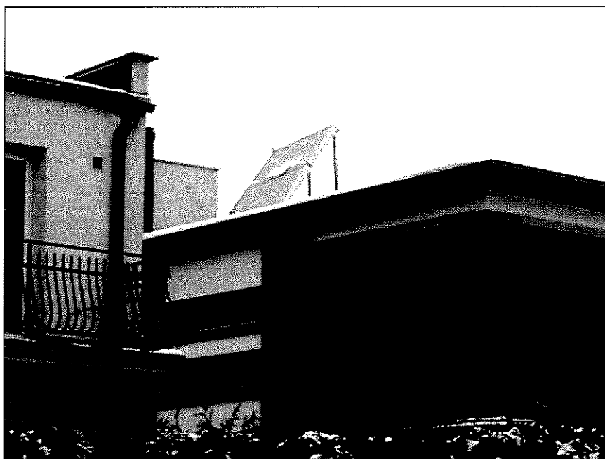
Rys. 15 Instalacja kolektorów słonecznych – Gostyń
