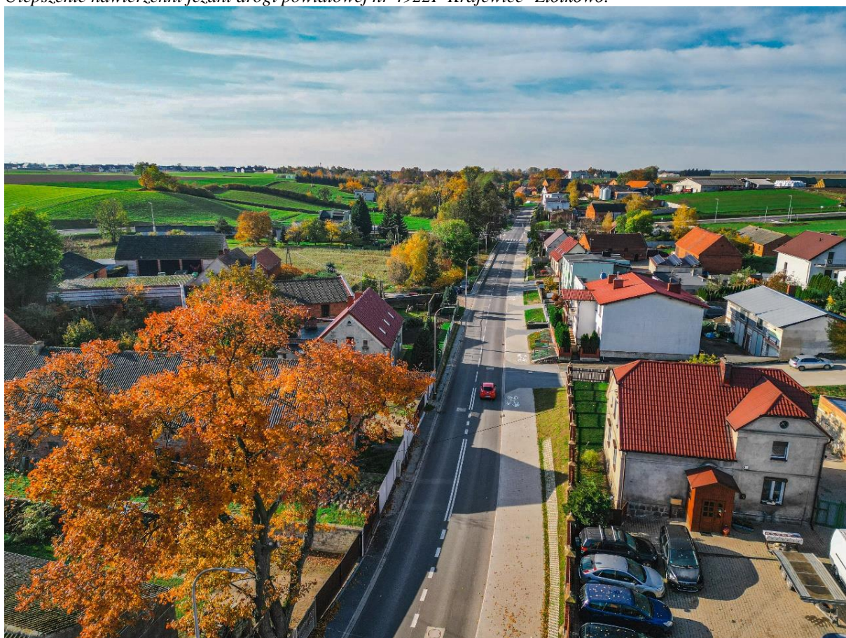
Przebudowa z rozbudową drogi powiatowej br 4906P Gostyń – Brzezie wraz z budową ciągu pieszo-rowerowego.
