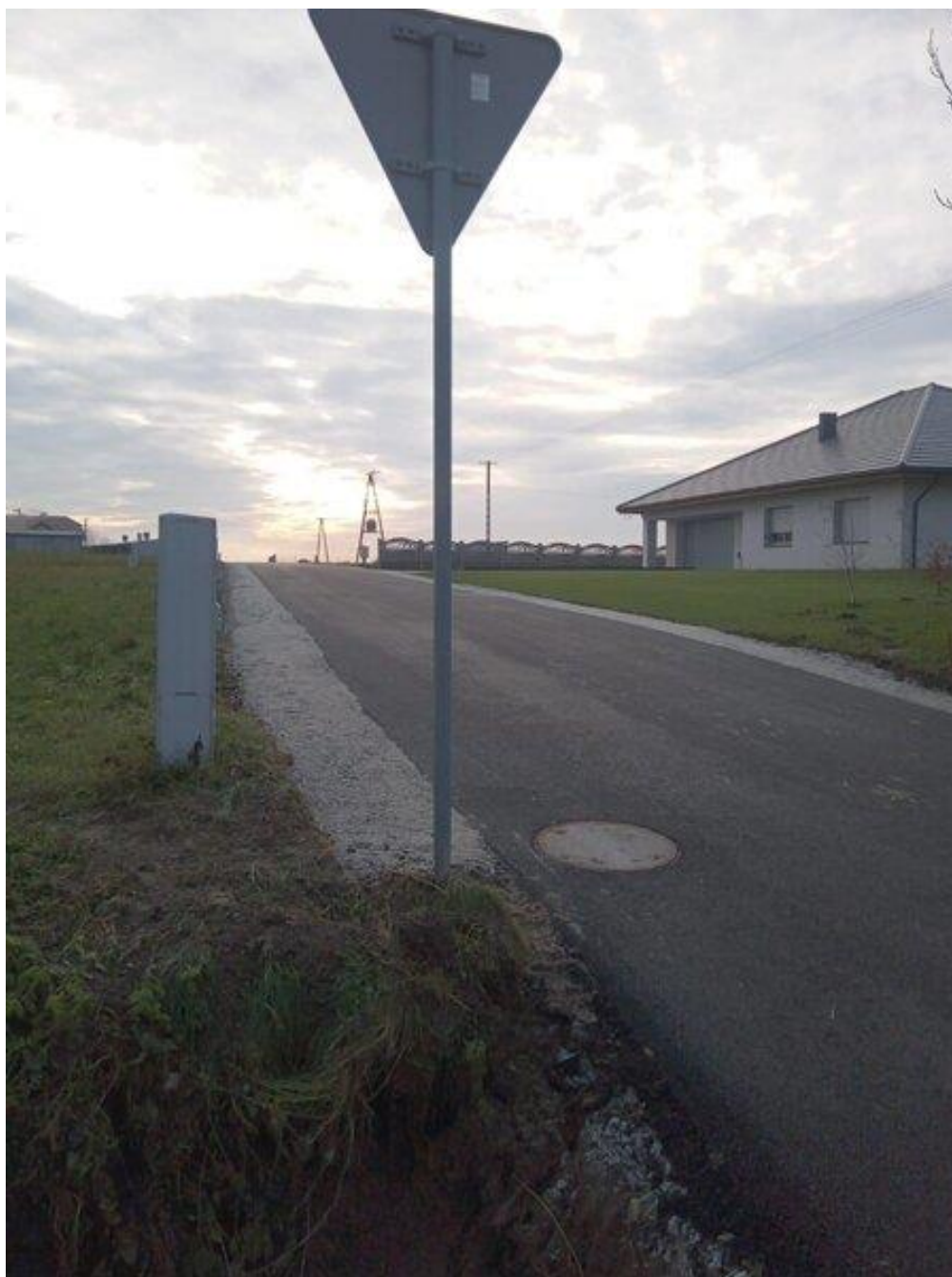
Budowa i modernizacja dróg gminnych.
