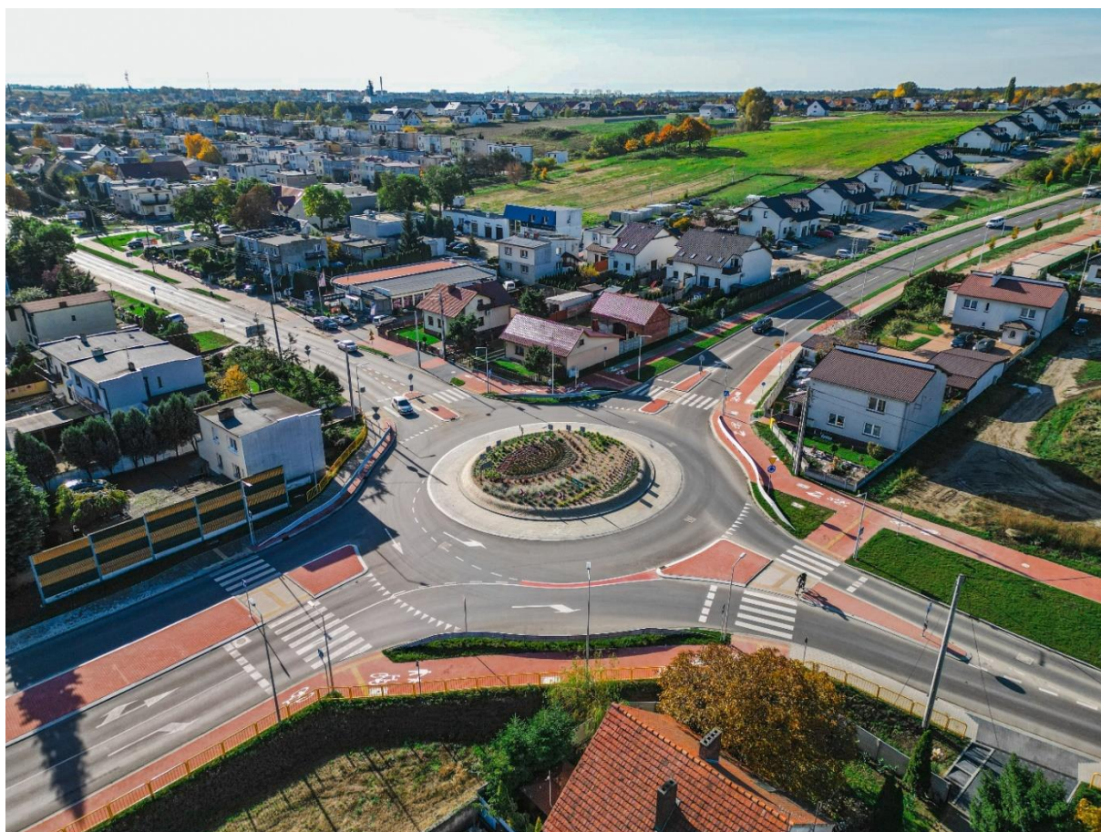
Przebudowa skrzyżowania ul. Nad Kanią z ul. Europejską.
