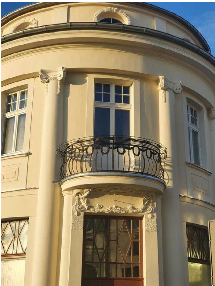
Modernizacja i przebudowa budynku przy ul. 1 Maja 1.
