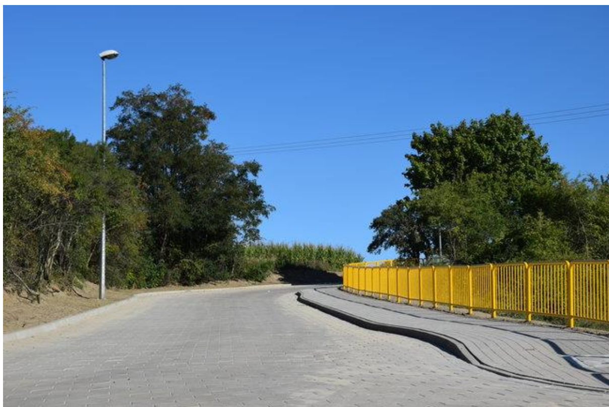
Budowa drogi w ul. Droga do Klasztoru w Gostyniu.
