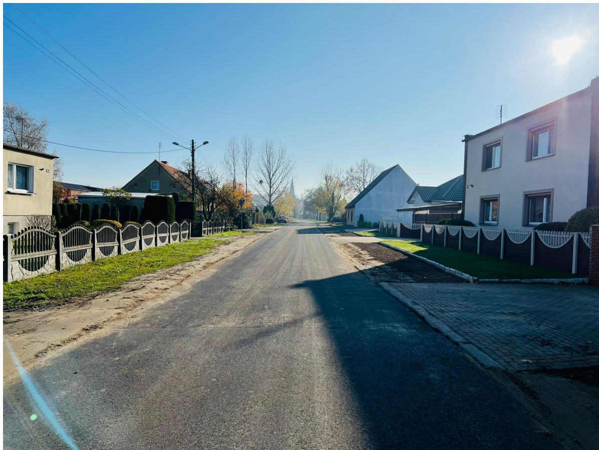
Budowa kanalizacji sanitarnej w m. Siemowo.
