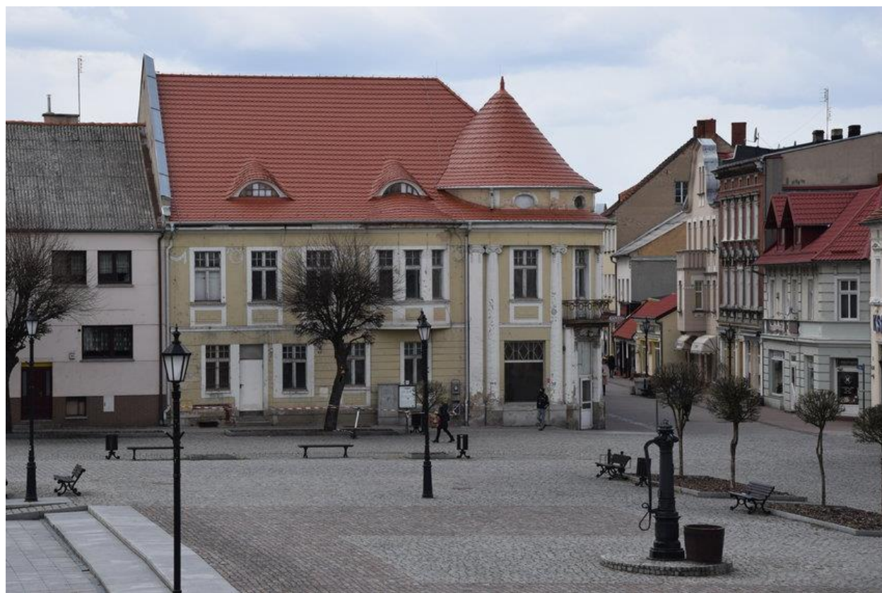
Wymiana pokrycia dachowego budynku przy ul. 1 Maja 1
