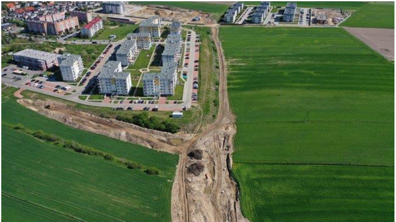
Budowa drogi łączącej ul. Leszczyńską z ul. Górną.
