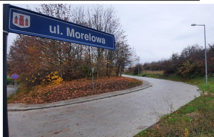
Remont nawierzchni przy ulicy Morelowej
