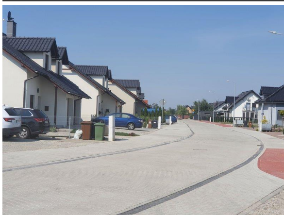
Utwardzenie drogi gminnej przy ulicy Reymonta
