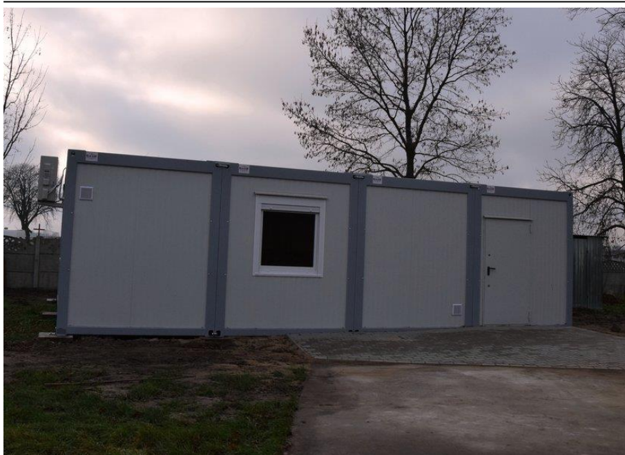
Kontenerowa świetlica wiejska w Tworzymirkach.
