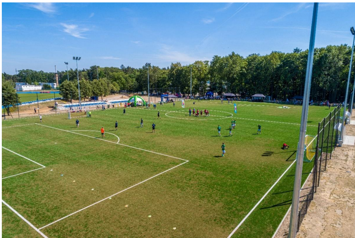
Przebudowa boiska treningowego o nawierzchni z trawy sztucznej.
