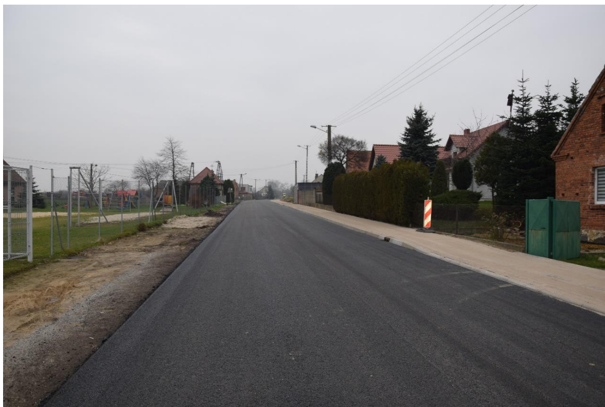
Przebudowa drogi w Czachorowie.
