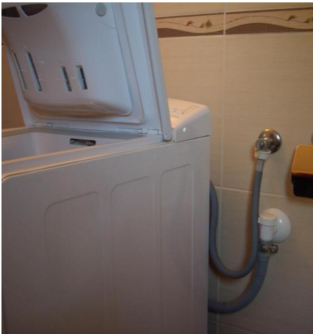
Fot. Sposób podłączenia pralki do instalacji wodociągowej i kanalizacyjnej. Zwracam uwagę na dodatkowe wzmocnienie węża na syfonie opaską metalową (w tym wypadku wykorzystano uchwyt do rury).
