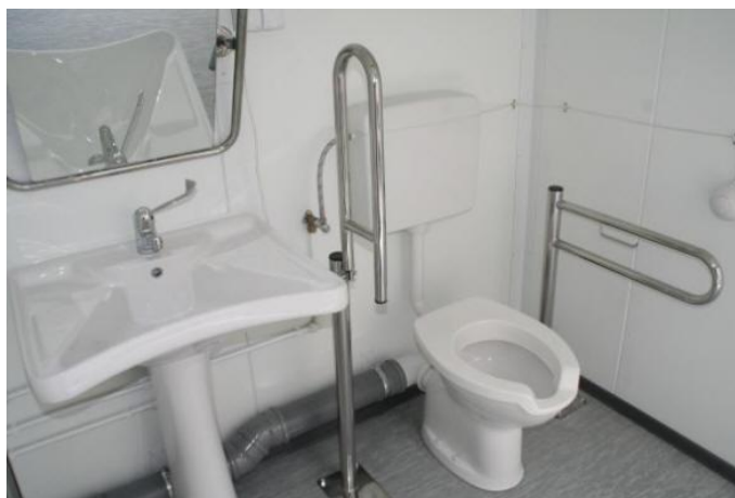
Fot. Muszla stojąca ze specjalnym wycięciem z przodu ułatwiającym podmywanie z uchwytyami podłogowymi. Po lewej stronie uchwyt uchylny. Na ścianie widoczny przycisk do pneumatycznego spłukiwania.
