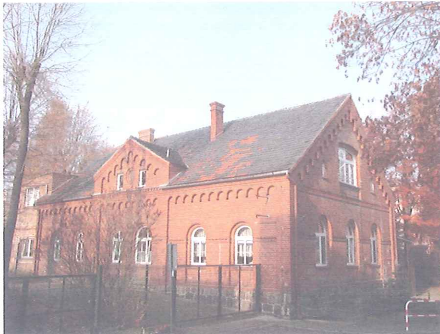
fot. 1 elewacja południowa i wschodnia
